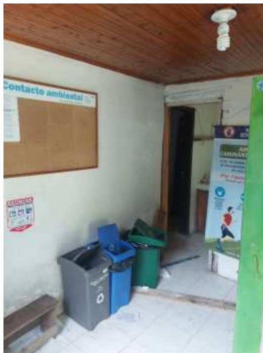
Fuente: Equipo Auditor, Contraloría Municipal de Pereira, 2022.
